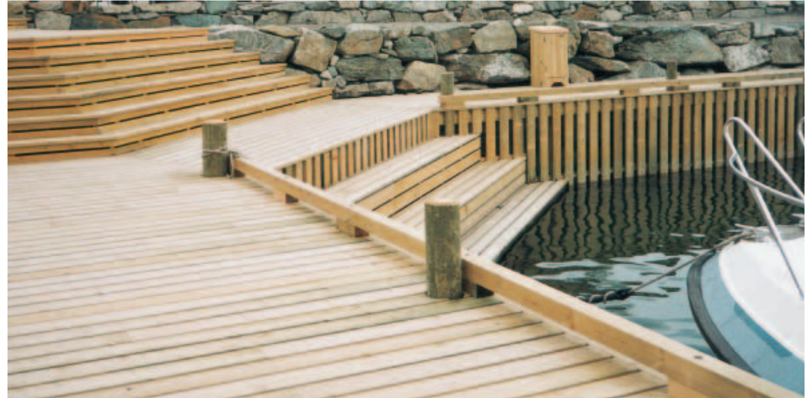
Denne trebryggen fra Våge på Tynesnes har stått modell for den nye bryggen i Tømmervågen borettslag.
